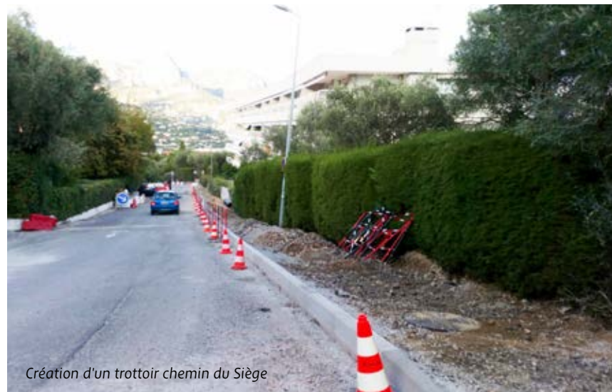
Création d'un trottoir chemin du Siège
