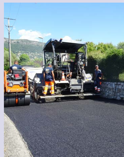
Réfection de chaussée chemin du Malbosquet
